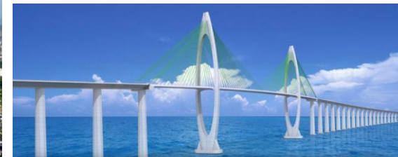
Ponte Salvador – Itaparica em Projeto. Fonte: SEDUR/SVO.
